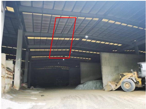
砂石堆场及喷淋系统
