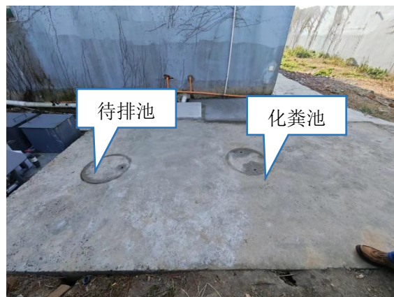
污水待排池及化粪池
